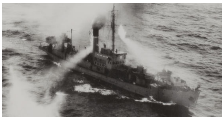
Letzte Ausbaustufe Das vordere Geschütz wurde gepanzert. Es kam hinzu: Räumotter am Bug und Aufbau am Heck. Beides diente der Räumung von Minenfeldern
