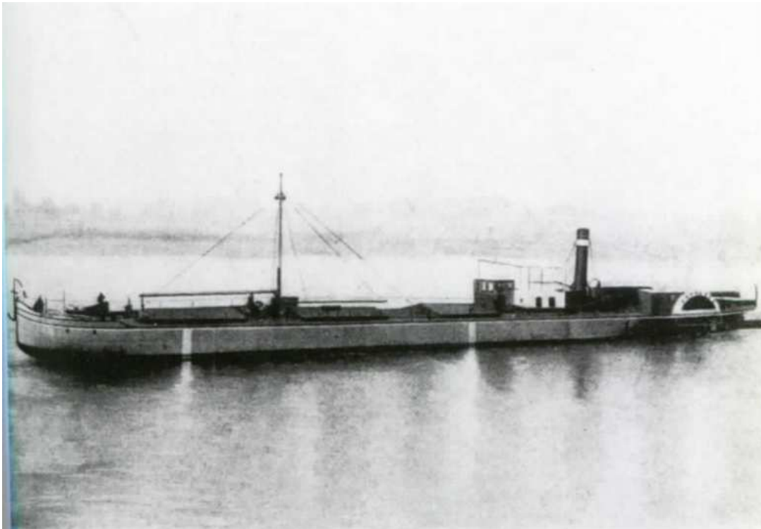
Heckraddampfer für 250 t Ladung für die Weser, eines der ersten selbstfahrenden Eil-Frachtschiffe (Atlas-Archiv).
